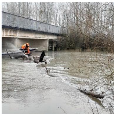
Retrait d'un embâcle à l'aval d'un ouvrage.
